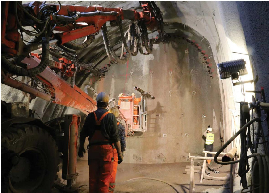
Slika 2-2 Ugradnja cijevi (Tunneling, Rock Support & Geotechnical Solutions by MIPL & ROBIT, 2019)
