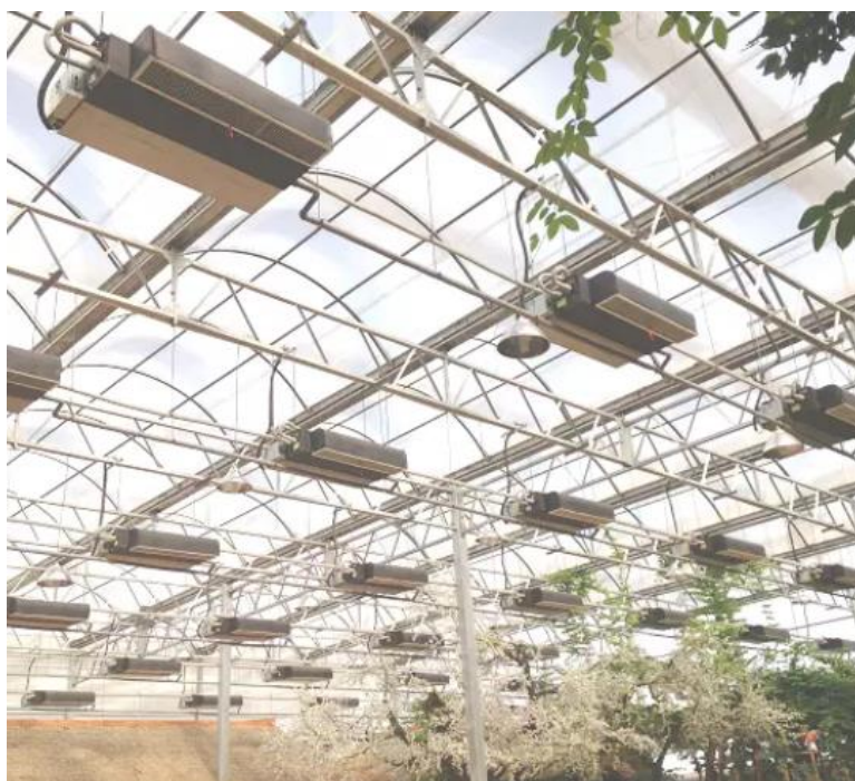
Slika 6-3. Stropni ventilokonvektor (Jindun Equipment, 2020)
