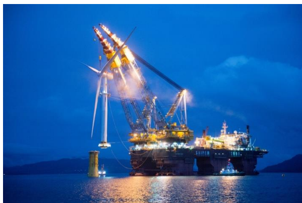
Slika 4-11. Postavljanje Siemens vjetroagregata na monopod (Izvor: Siemens Gamesa)
