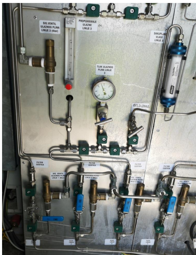
Slika 5-3. Sustav za obradu uzorka
