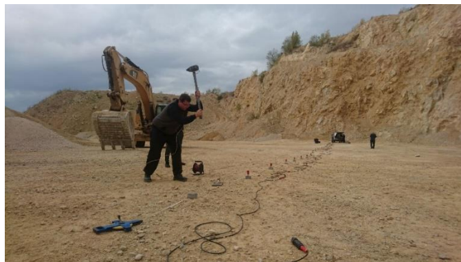
Slika 6.25. Provođenje terenskih geofizičkih ispitivanja na platou kamenoloma Špica
