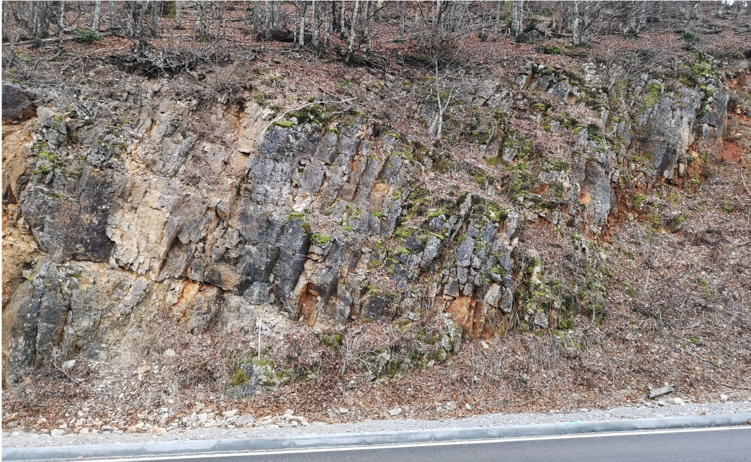
Slika 5-3 Inženjerskogeološka zona Z-1 - pogled na zonu.
