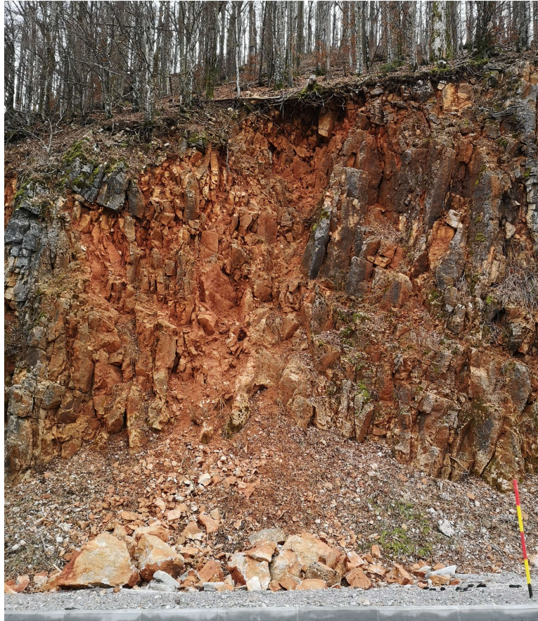
Slika 5-9 Inženjerskogeološka zona Z-4 - pogled na zonu.
