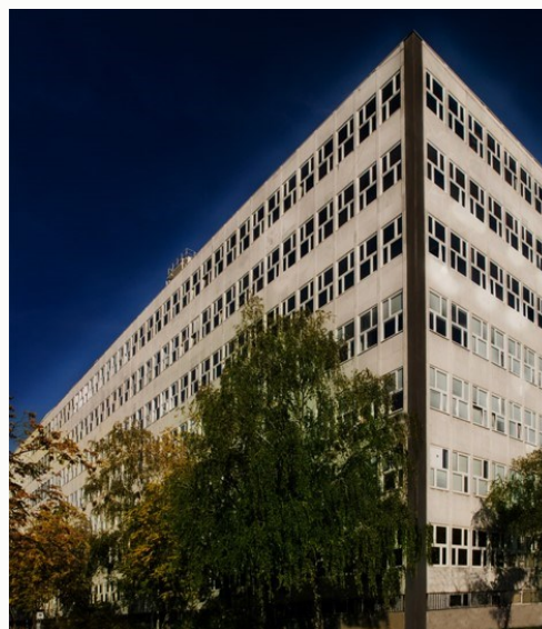
Zgrada Rudarsko-geološko-naftnog fakulteta u Pierottijevoj 6
