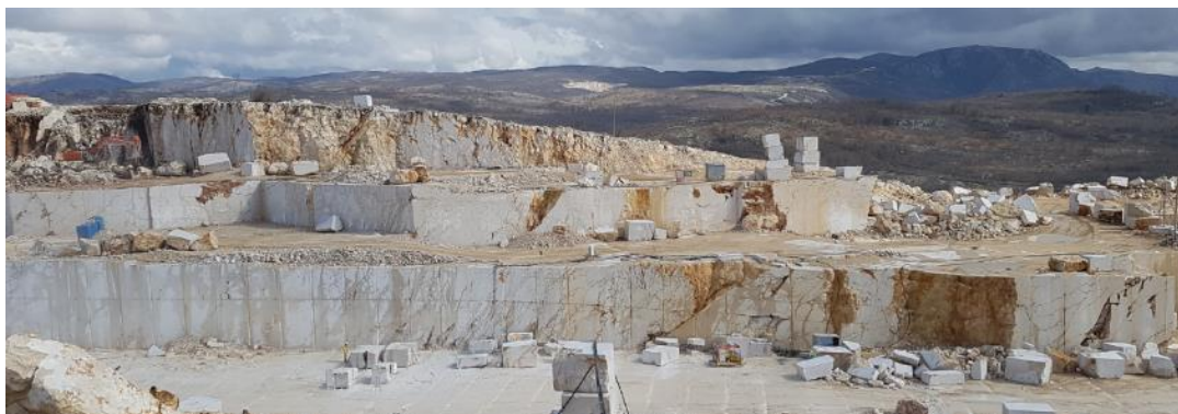
a) Pogled 1, istočna strana površinskog kopa
