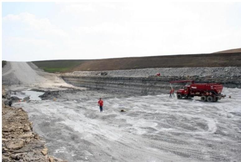
**Slika 3-4.** Proizvodnja ANFO eksploziva na mjestu upotrebe (<http://dykonblasting.com/portfolio/weeping-water-quarry-quarry-blasting/>)
