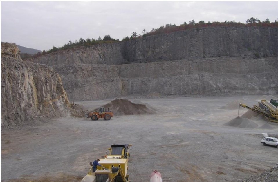
Slika 2.3 Kamenolom 'Sveti Ivan' nedaleko od Buzeta u kojem se foraminiferski vapnenci eksploatiraju kao tehničko–građevni kamen.
