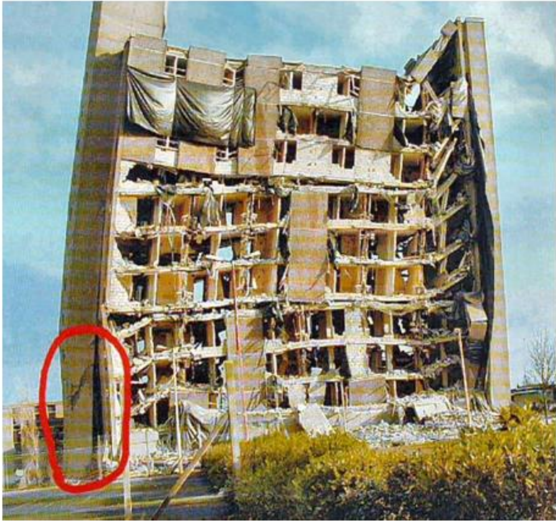
Slika 2-5. Neuspjelo rušenje (Ester Z., Dobrilović M., 2016.)
