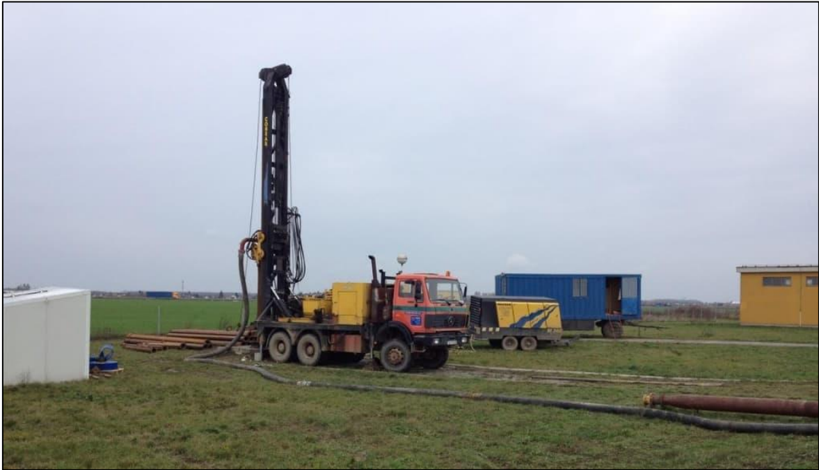
Slika 3-2. Reversna hidraulična samohodna bušača garnitura CONRAD (Vodovod Osijek, 2020)
