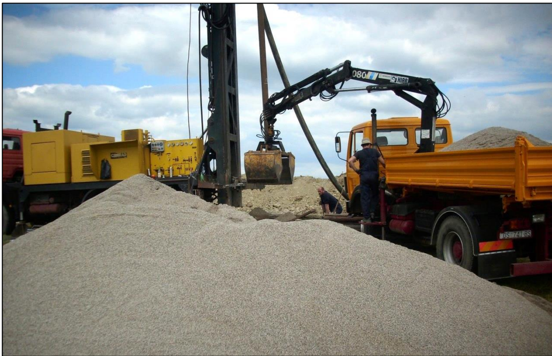
Slika 3-4. Ubacivanje šljunčanog zasipa (fotografija Željka Duića)
