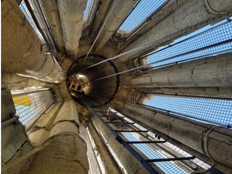
Slika 4-2. Unutrašnjost tornja (Bohanek i Dobrilović, 2020 )
