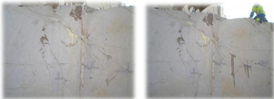
Slika 7.26. Utiskivanje urea silikatne smole u utisnu bušotinu B1
