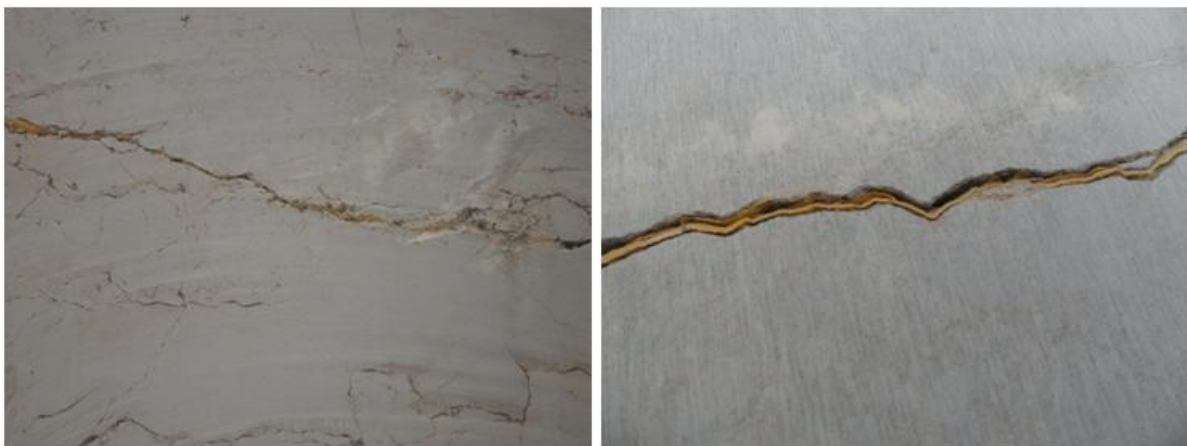
Slika 7.39. Prikaz nezapunjenih pukotina, s lističavim ljepilom
