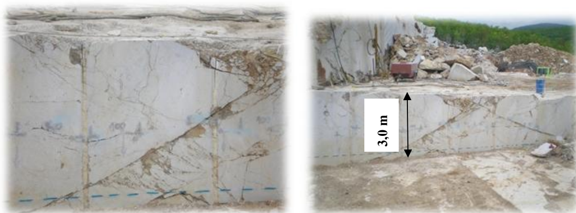
Slika 7.6. Rasjed oznake 10 (položaj 228/45) na zapadnom čelu i pogled na zapadno čelo
