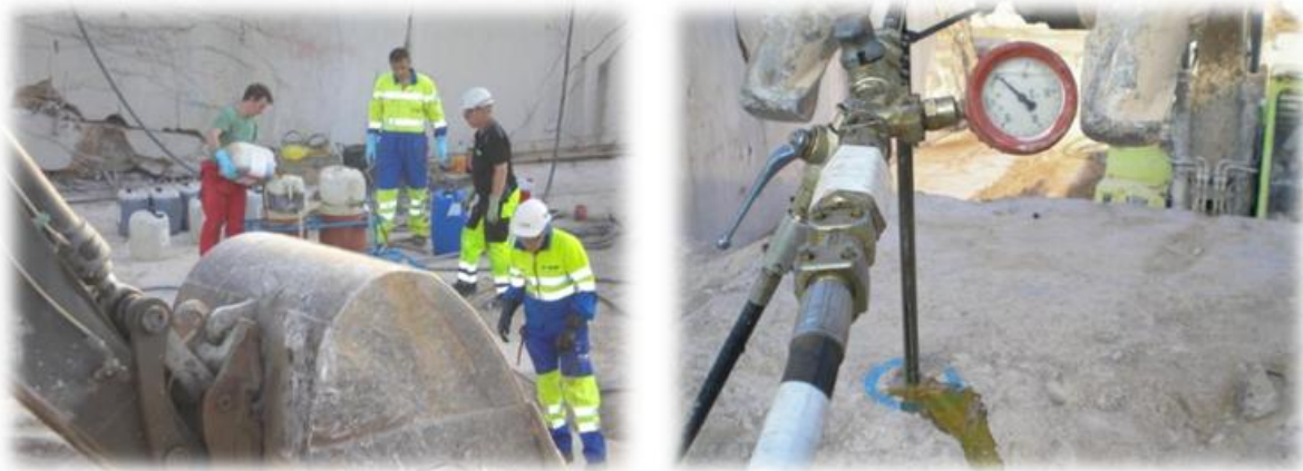
Slika 7.25. Utiskivanje urea silikatne smole u utisnu bušotinu B5
