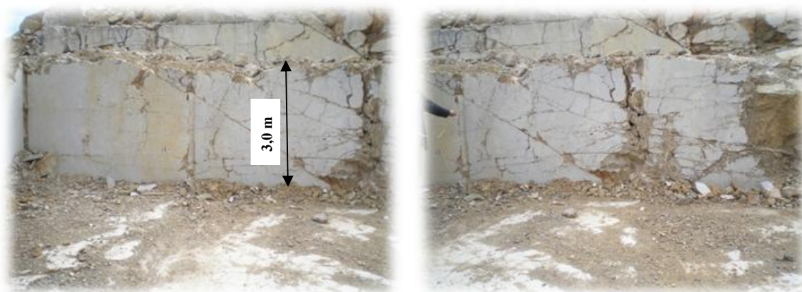
Slika 7.9. Rasjed i pukotine evidentirane na istočnom čelu
