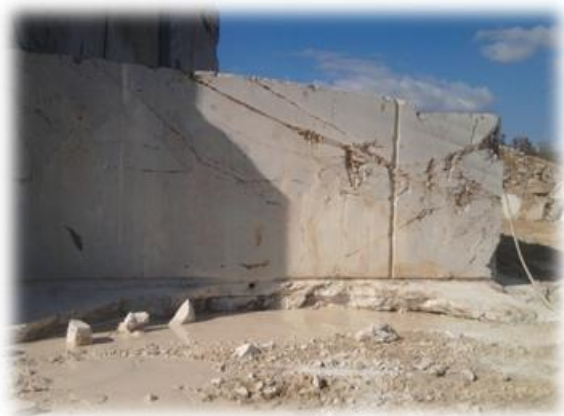
a) Sjeverni dio novog čela etaže
