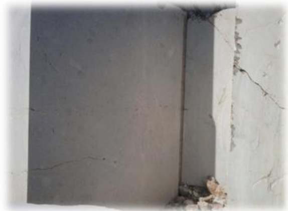
b) Izrađeni trapezni usjek
