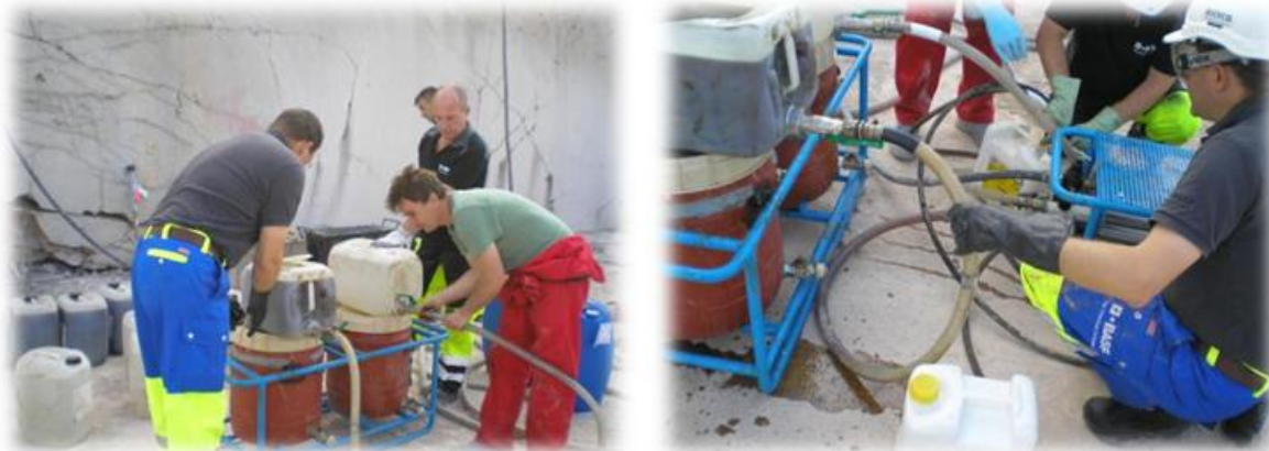
Slika 7.23. Spajanje viskotalčnih cijevi na razervoare
