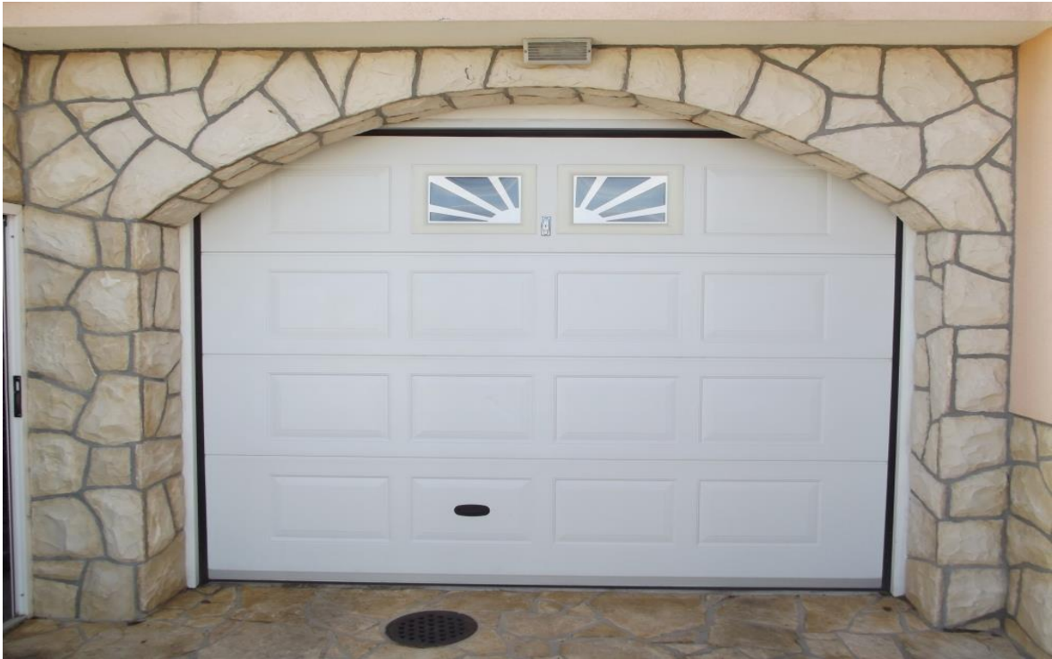
Slika 4-2. Ulaz u garažu obložen bijelim izbijenim ciklopom
