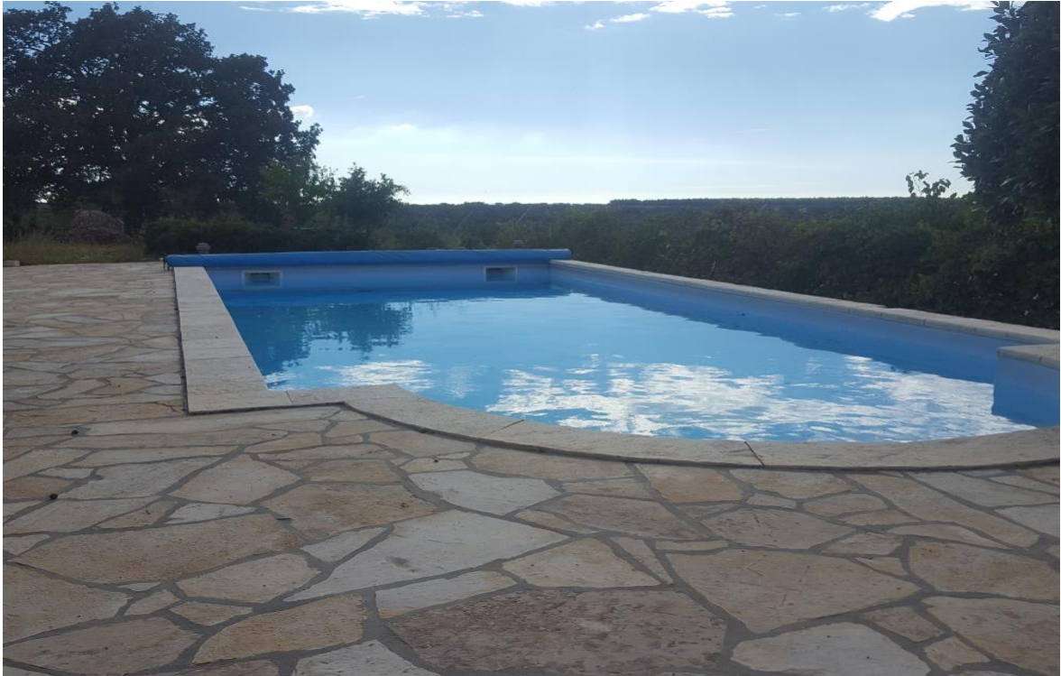
Slika 4-3. Staza oko bazena obložena lomljenom pločom
