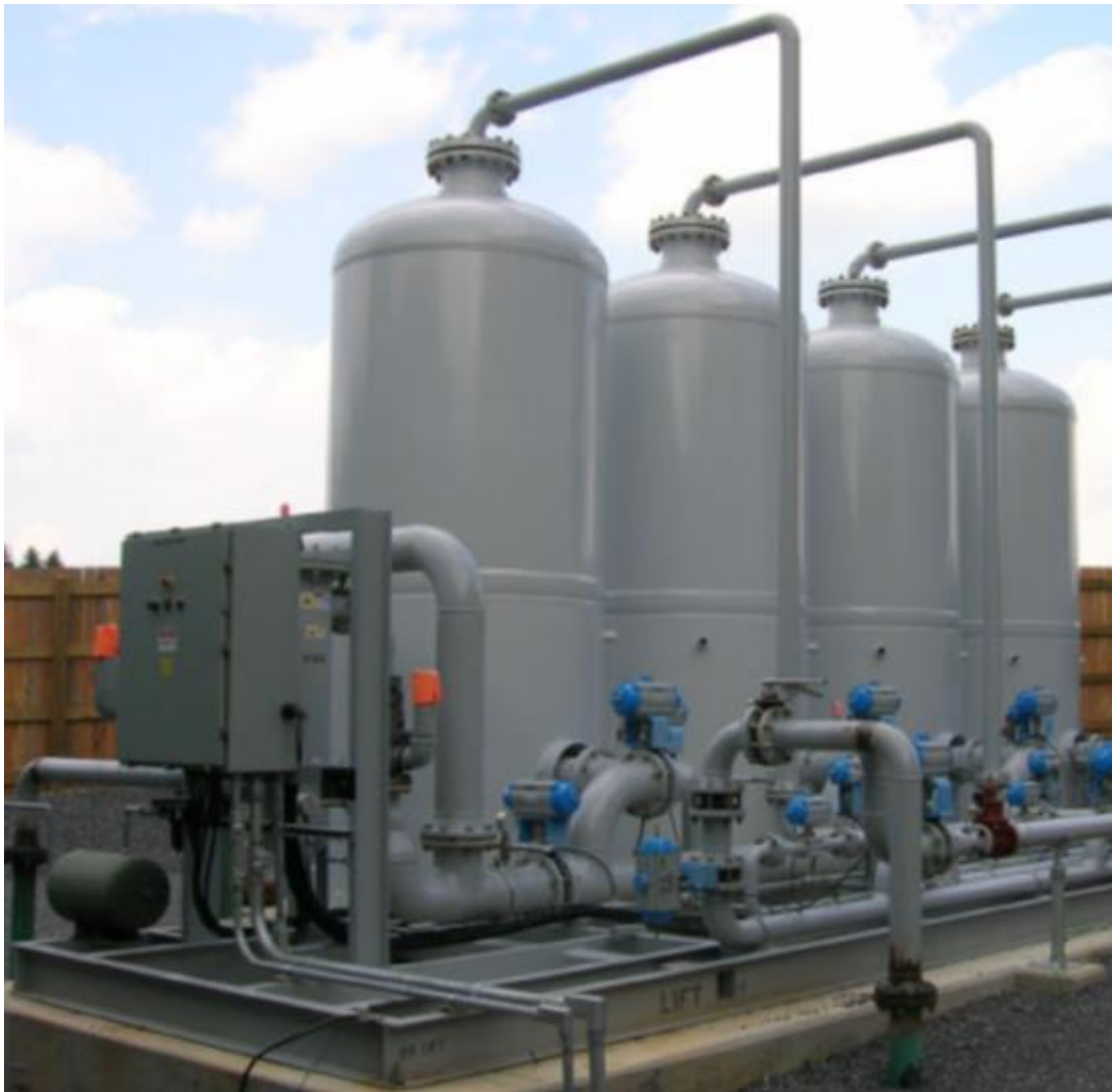
Slika 2-4. Molecular Gate jedinica za izdvajanje dušika iz struje prirodnog plina za protoke od 2360 m 3 /h do 4720 m 3 /h (2-4 MMscfd) (Mitaritan, 2002)
