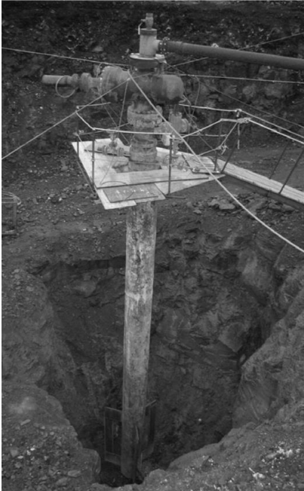
Slika 3-8. Zamjena zaštitne cijevi zbog propuštanja u blizini ušća bušotine (Thorhallsson, 2003)
