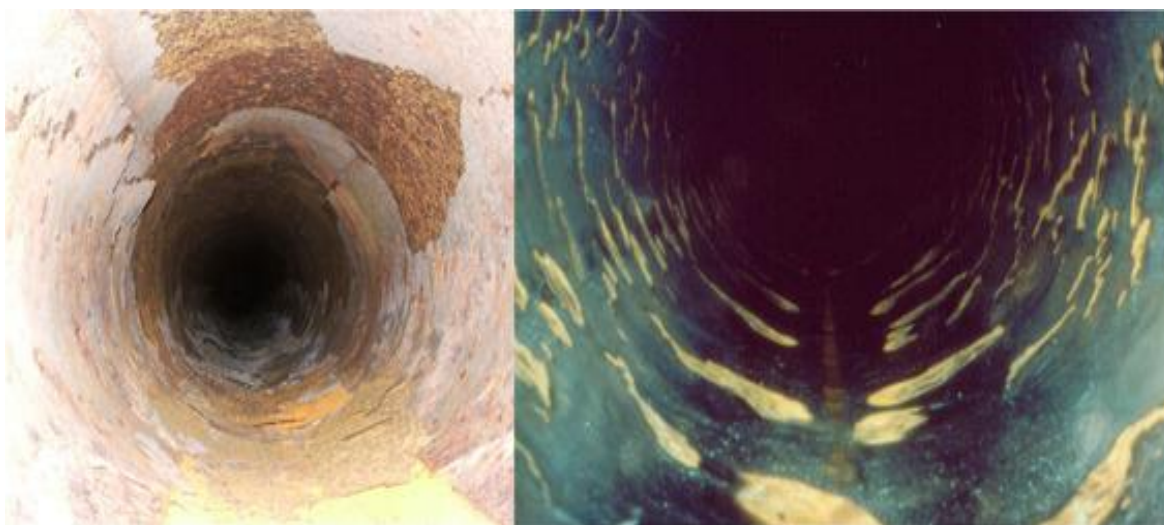
Slika 3-6. Korodirane zaštitne cijevi iz geotermalne bušotine (Nogara i Zarrouk, 2018)
