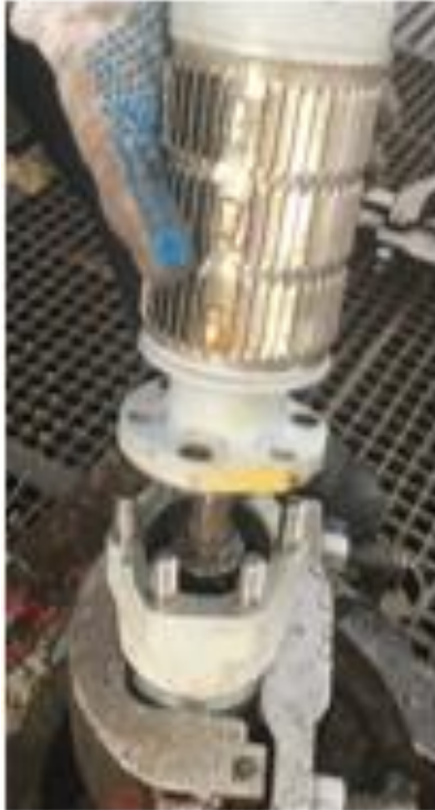
Slika 4-12. Postavljanje plinskog separatora (INA d.d., 2019)
