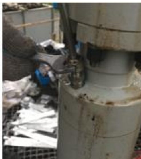
Slika 4-14. Punjenje i montaža kapilarnog voda (INA d.d., 2019)
