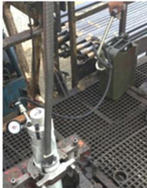
Slika 4-9. Prikaz dotezanja spoja moment ključem i protiskivanja ulja (INA d.d., 2019)
