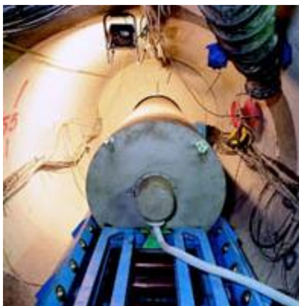
Slika 2-15. Ugradnja grijača u bentonitni blok (Grimsel, 2020)
