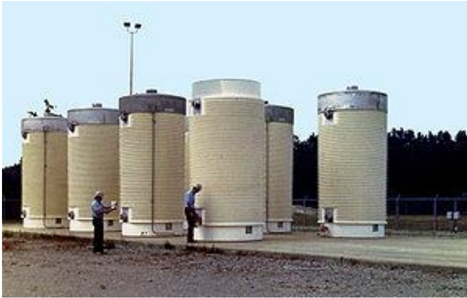
Slika 2-5. Spremnici za suho skladištenje istrošenog nuklearnog goriva
