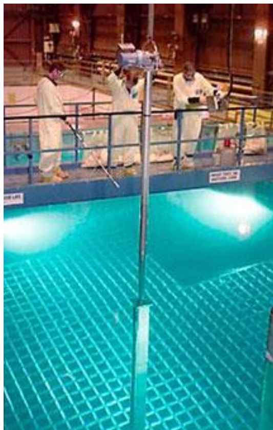
Slika 2-3. Bazen s bornom vodom za privremeno skladištenje ING-a
