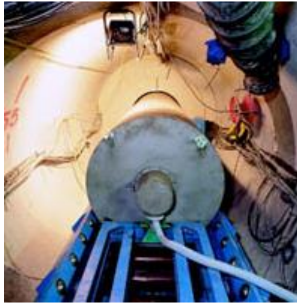
Slika 2-15. Ugradnja grijača u bentonitni blok (Grimsel, 2020)
