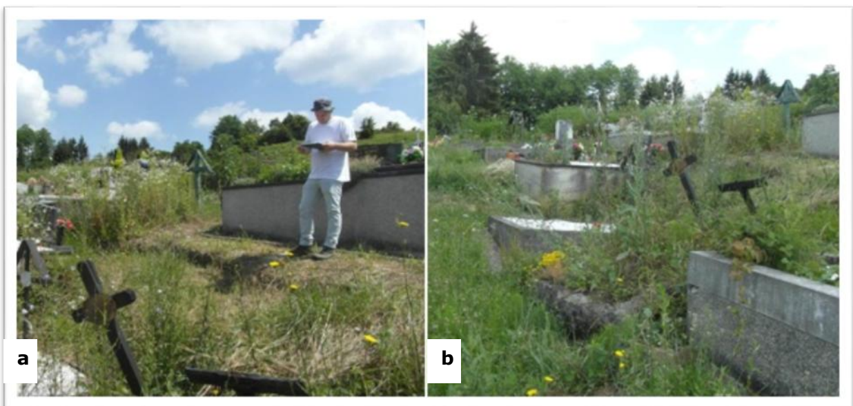
Slika 3. 3 Klizište 2 (snimljeno 27.6.2014.): (a) pogled na krunu klizišta, odnosno glavnu pukotinu; (b) oštećeni grobovi ispod glavne pukotine.
