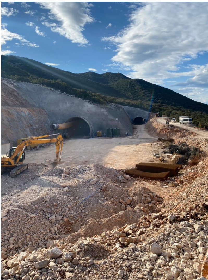
Slika 3.1-1 Izlazni portal sa glavnom cijevi (lijevo) i servisnom cijevi (desno) – tunel „Supava“
