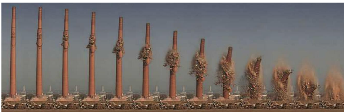
Slika 3-4-1. Rušenje dimnjaka pomoću eksploziva (Martin-Consuegra, 2021)
