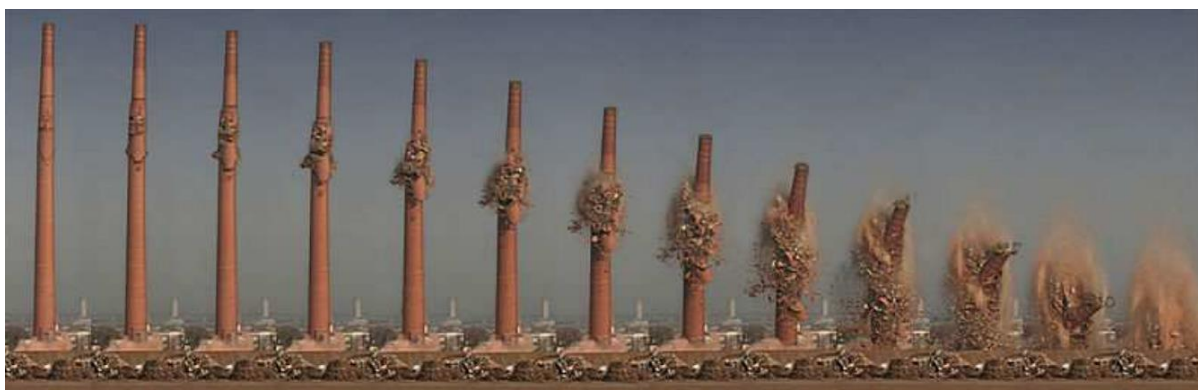
Slika 3-4-1. Rušenje dimnjaka pomoću eksploziva (Martin-Consuegra, 2021)
