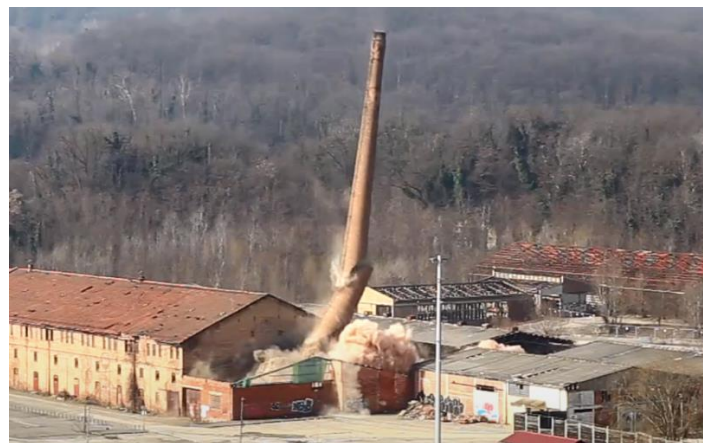
Slika 5-2. Rušenje rotacijom dimnjaka ciglane Zagreb (Stanzi, 2021)
