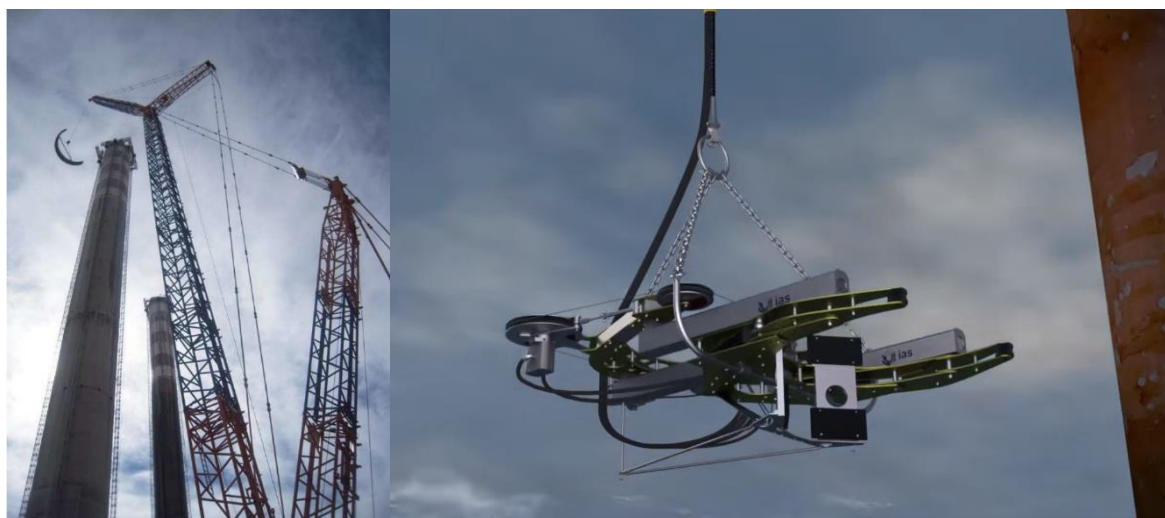
Slika 3-1-1. Rušenje dimnjaka dijamantnom žicom (IAS Group)
