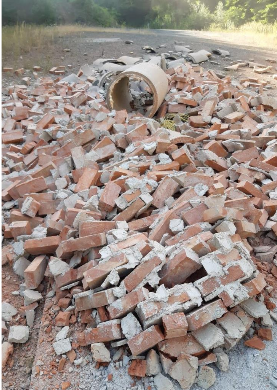
Slika 11-5 Učinak eksploziva na betonskom dimnjaku
