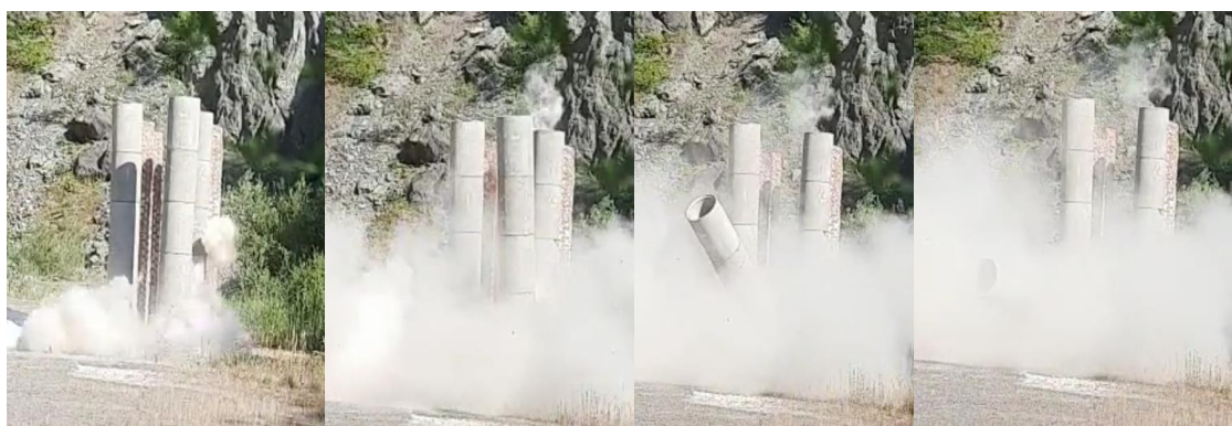
Slika 11-1 Miniranje betonskih dimnjaka
