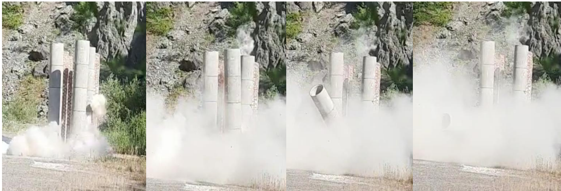
Slika 11-1 Miniranje betonskih dimnjaka
