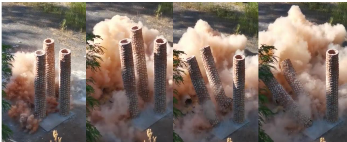
Slika 11-2 Miniranje betonskih dimnjaka
