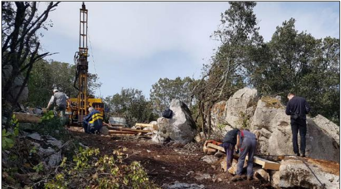
Slika 2-4. Prikaz istražne bušilice u radu na bušotini B7 (Galić i dr., 2020.)
