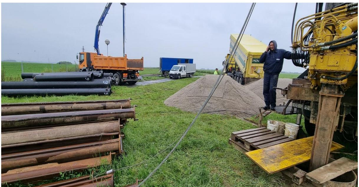
*Slika 6: Bušenje zdenca Z-14 reverznom metodom*
