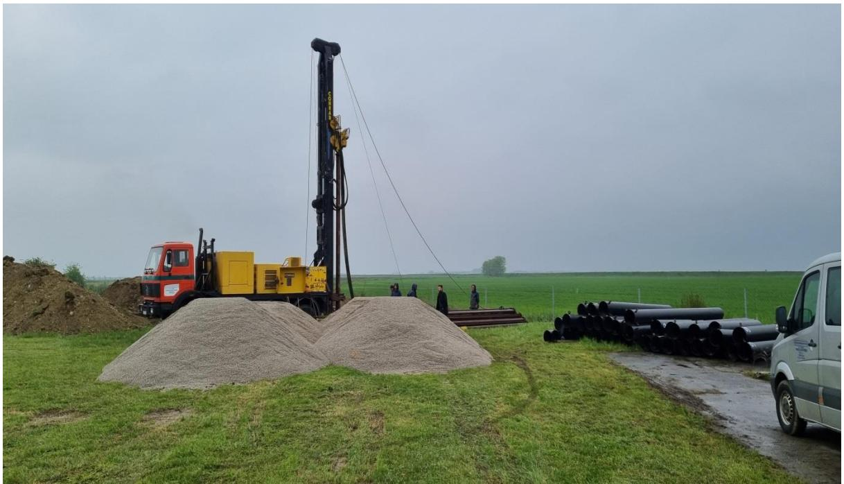
*Slika 5: Reverzna hidraulična samohodna bušača garnitura CONRAD-COMAX 800 MK2
