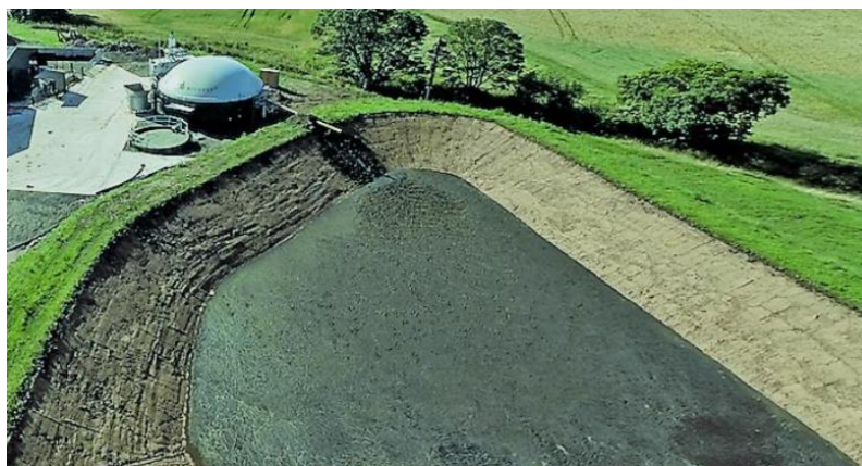
Slika 4-6. Skladištenje digestata u laguni (EIHP, 2018)
