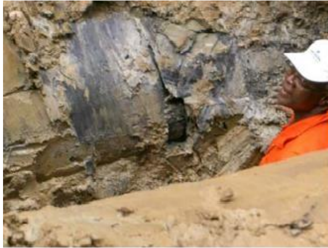
Slika 2-4. Nepostojanje premaza locirano mjerenjem gradijenta napona istosmjerne struje (Nicholson, 2006)
