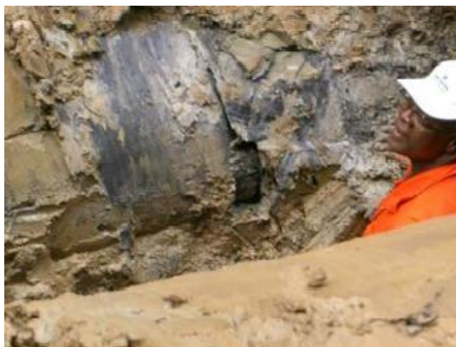
Slika 2-4. Nepostojanje premaza locirano mjerenjem gradijenta napona istosmjerne struje (Nicholson, 2006)
