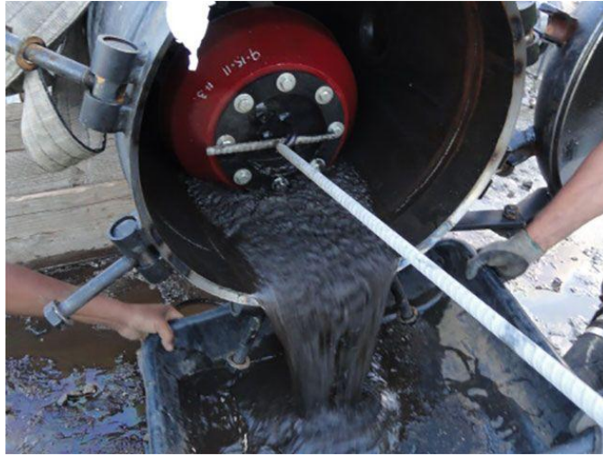
Slika 3-2. Nečistoće skupljene protiskivanjem čistača cjevovoda ( https://www.piping-world.com/ , 2019)
