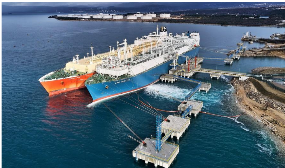
Slika 2-4. UPP terminal u Omišlju, Krk (LNG Hrvatska, 2021)
