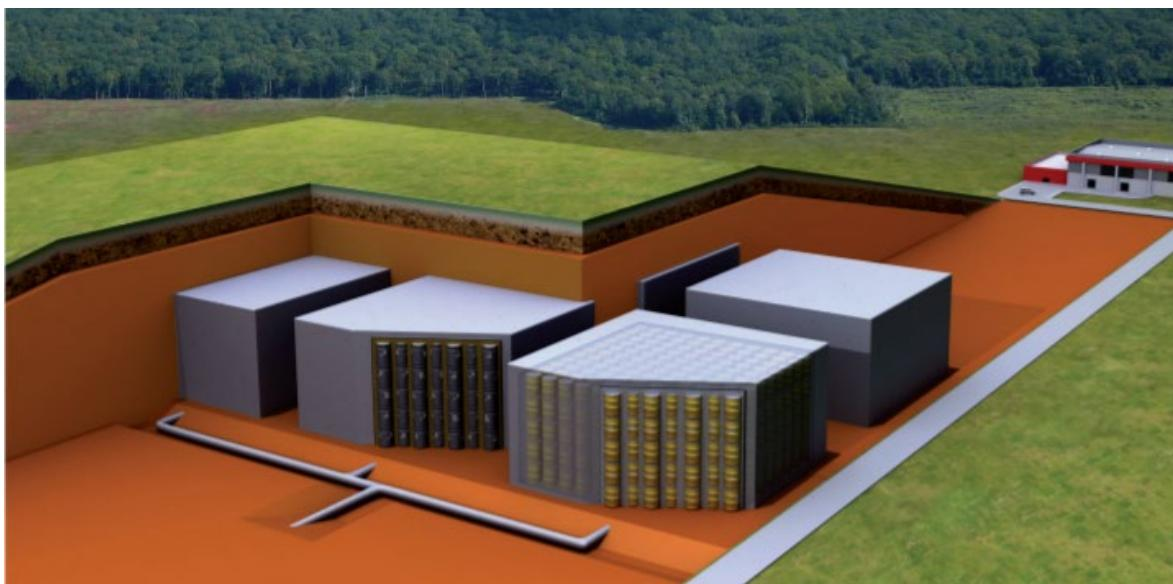
Slika 2.9. Prikaz presjeka odlagališta l'Aube, betonskih kaseti napunjениh otpadom i zatvorenim betonskim poklopcem, drenažni sloj za odvodnju oborinskih voda te konačno zatrpane kasete s debelim slojem gline (Andra, Nuclear waste in France).
