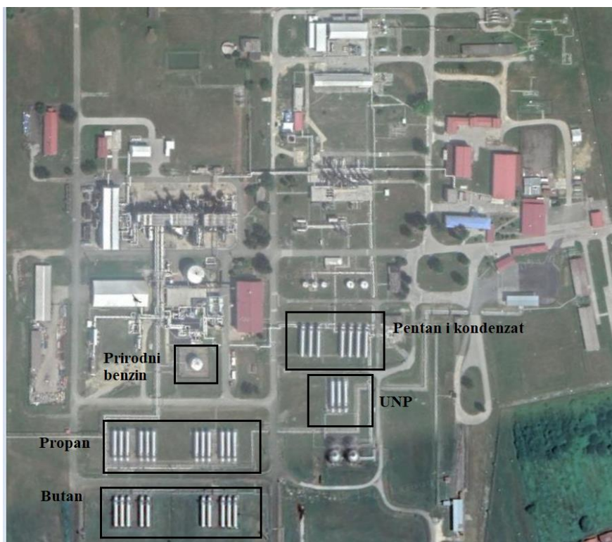
Slika 5-2. Spremnički prostor na području postrojenja OFIG (Google Earth, 2021)
