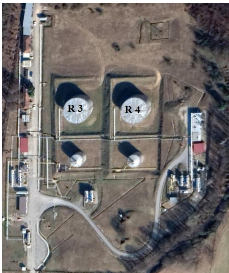
Slika 5-8. Naftni spremnici na OS Šandrovac (prema INA d.d., 2016a)
