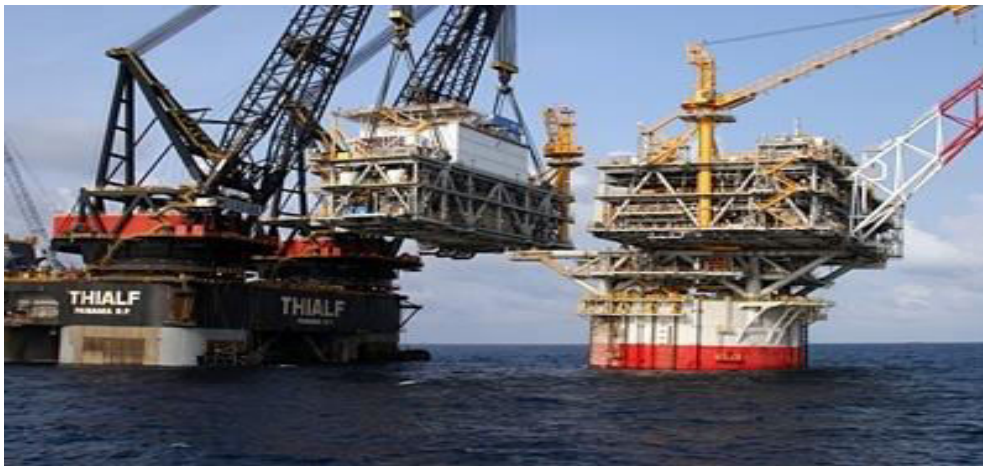
Slika 2-8. Postavljanje nadgrađa spar platforme barža dizalicom za težak teret (www.quora.com)
