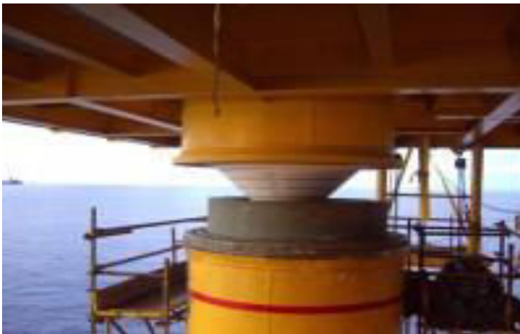
Slika 2-9. Spajanje nadgrađa s trupom spar platforme ( www.offshorekinematics.com )
