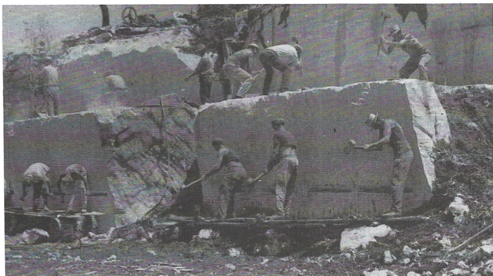
Sl. 11. Kamenolom vapnenca istarski žuti Selina u Istri. Na lijevom bloku jedna grupa radnika izraduje formele duž slojnice, a druga pneumatskim čekićem buši vertikalne rupe. Na lijevom bloku jedna grupa radnika pobija klinove u formelama, a druga u vertikalnim bušotinama (foto: J. Tišljar, 1963)
