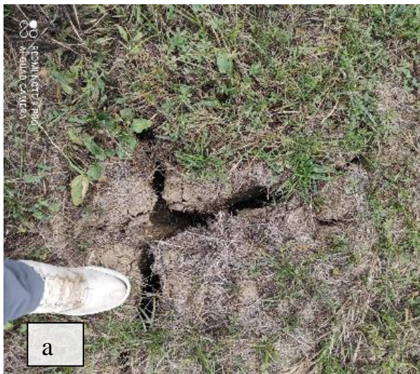
Slika 6.8 Jače sezonske pukotine na nasipu: (a) lokalno; (b) duž krune nasipa
