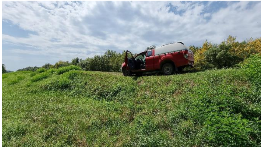
Slika 6.7 Jače slijeganje nasipa
