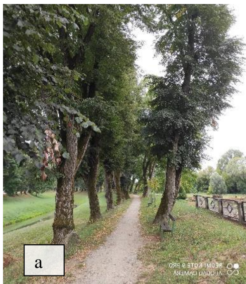
Slika 6.9 Viša vegetacija na: (a) kruni nasipa; (b) pokosu nasipa
