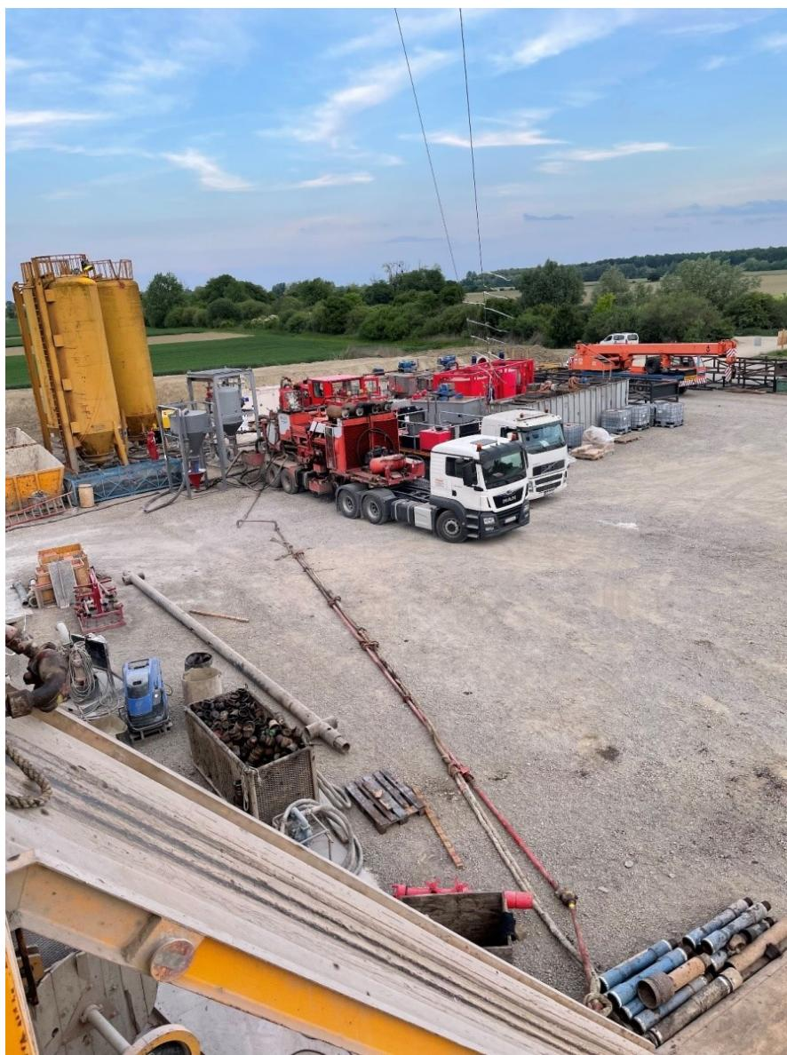
Slika 2-2. Oprema za izvođenje cementacije na kopnu
