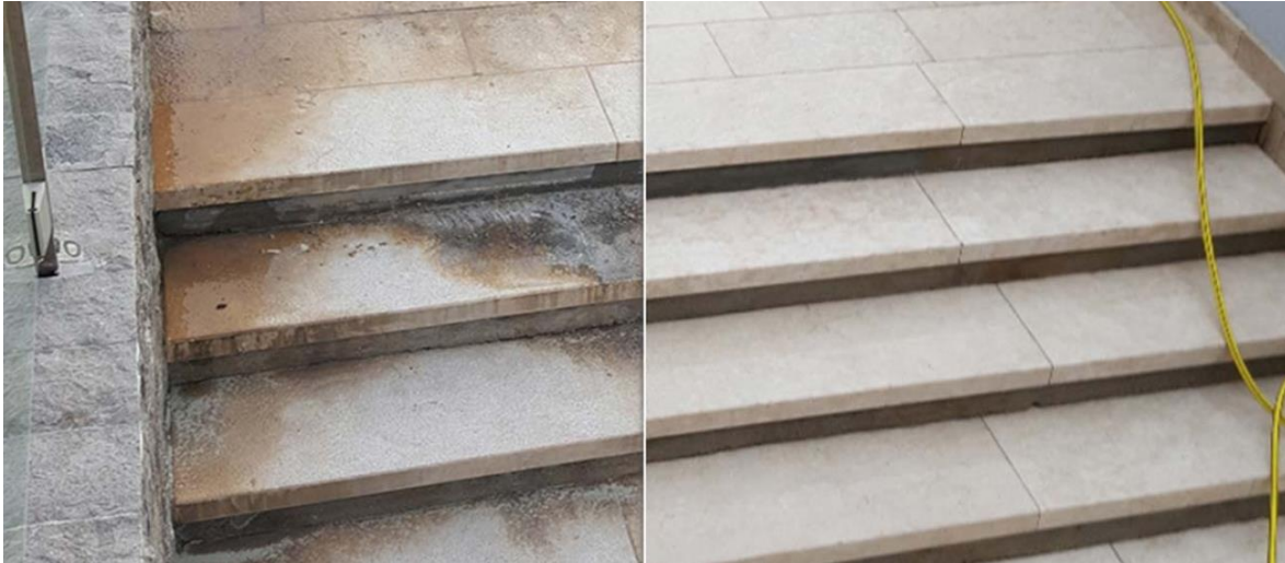
Slika 7-7. Prikaz ploča ugrađenih na vanjsko stepenište prije i poslije tretmana pjeskarenja
