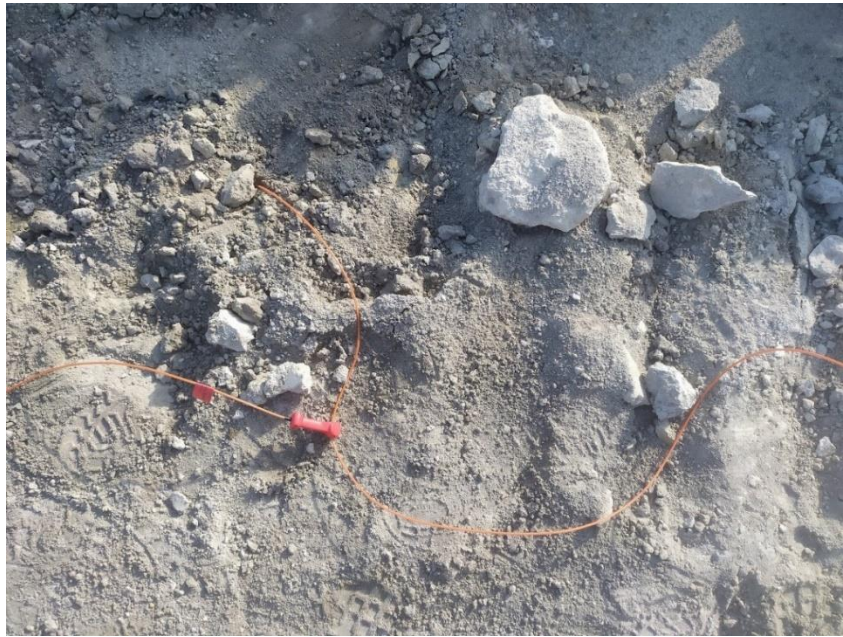
Slika 6-4 Spajanje minskih bušotina u redu
