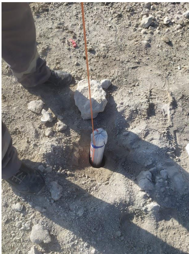
Slika 6-3 Postavljanje patrone u bušotinu
