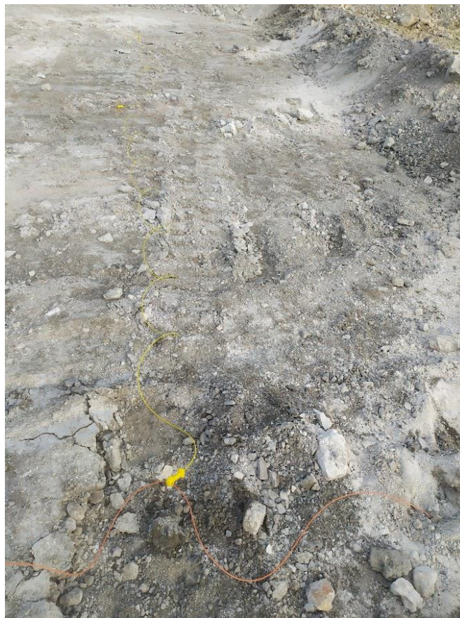
Slika 6-5 Spajanje redova minskih bušotina konektorima (žuto)
