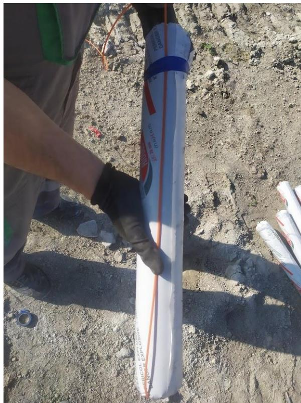
Slika 6-2 Spajanje patronе i neelektričnog detonatorа
