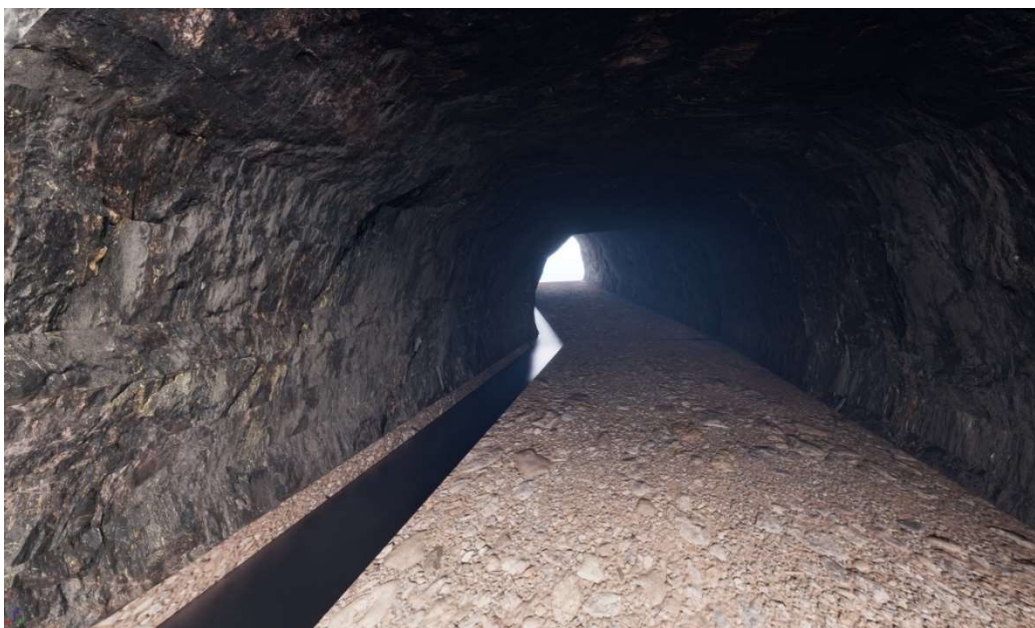
Slika 3-4. Spojena dva segmenta rudnika iznutra
