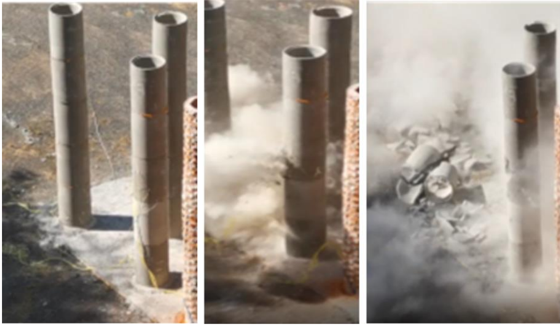
Slika 6-2. Djelomično neuspjelo rušenje dimnjaka (Katalinić et al, 2021)
