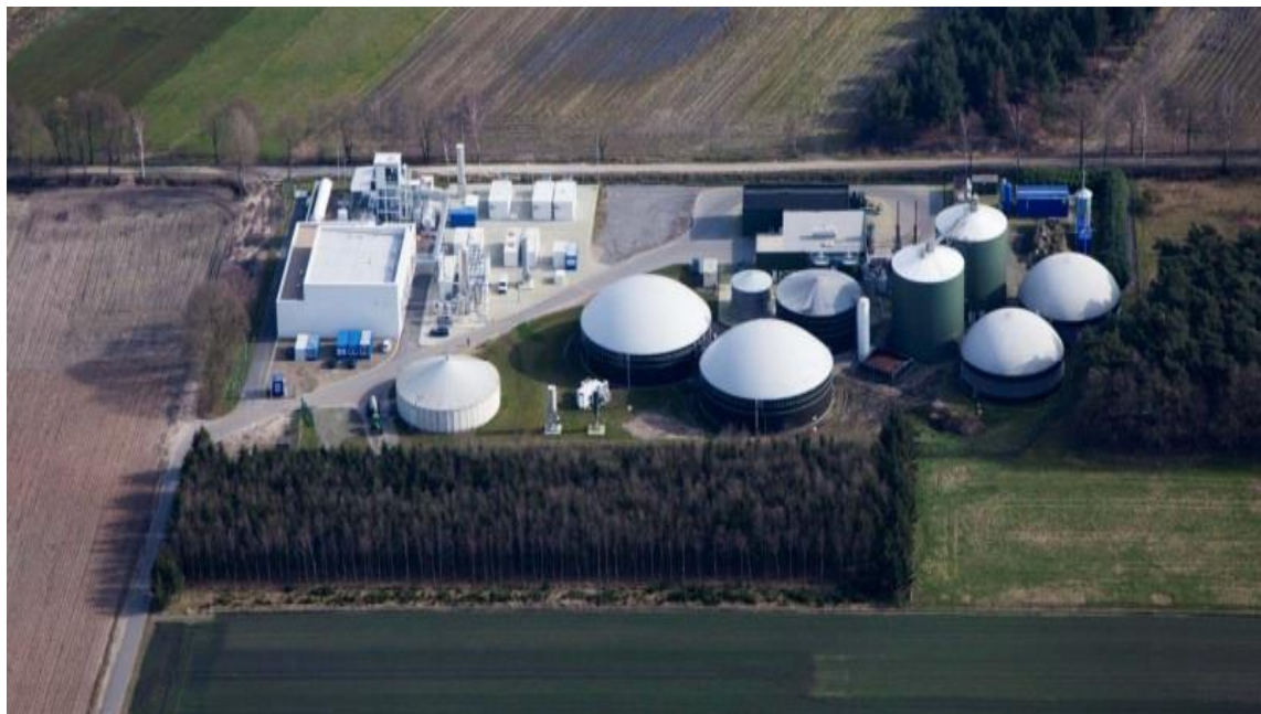
Slika 3-8. Postrojenje Audi e-gas, Werlte, Njemačka (Otten, 2014)
