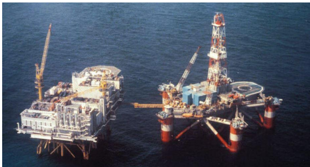
Slika 5-1. Platforme Edda 2-7C i Alexander L. Kielland (Safety4sea, 2019).
