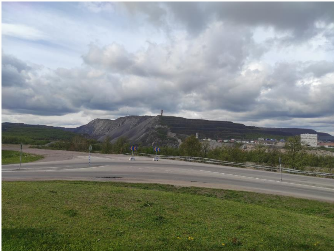
Pogled na površinski dio rudnika Kiruna (zgrada s uredima smještena uz sam rudnik visoka je 12 katova)
