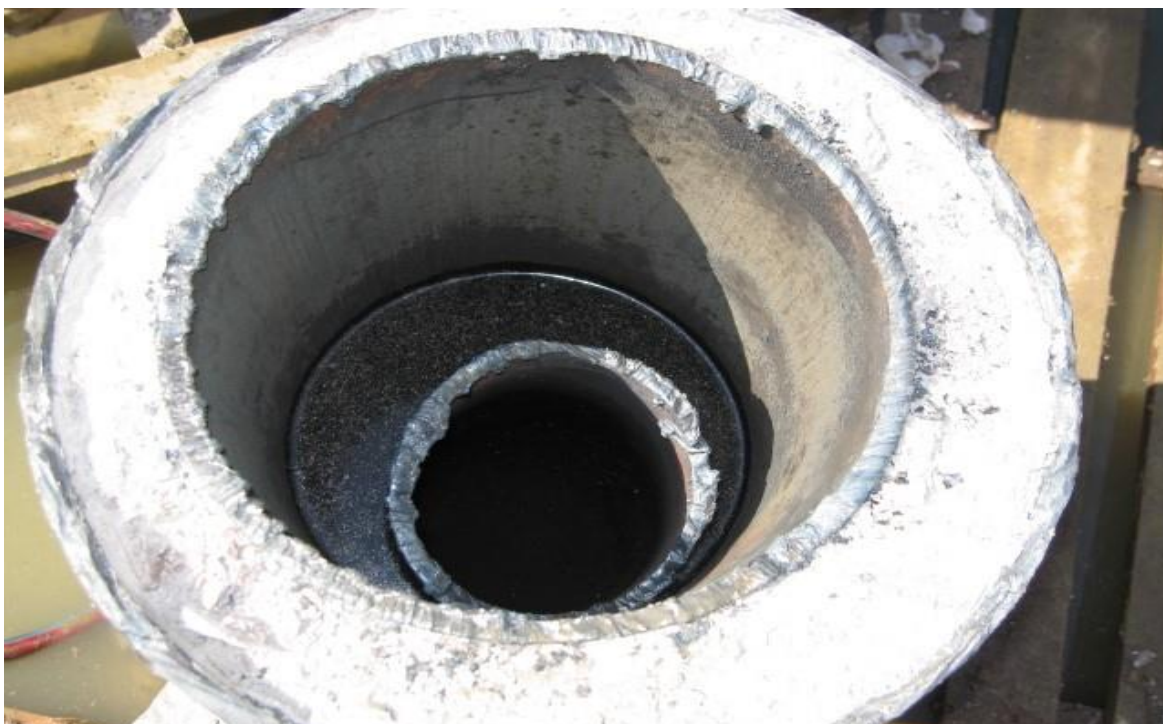
Slika 4-1. Prikaz ugrađenih i cementiranih nizova zaštitnih cijevi – 339,7 mm – 244,5 mm – 139,7 mm (CROSCO d.d., 2008)
