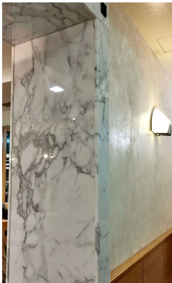
Slika 5-27 Mramorne ploče postavljene na okvir vrata u Vincek slastičarnici (foto: V. Apostolovski)
