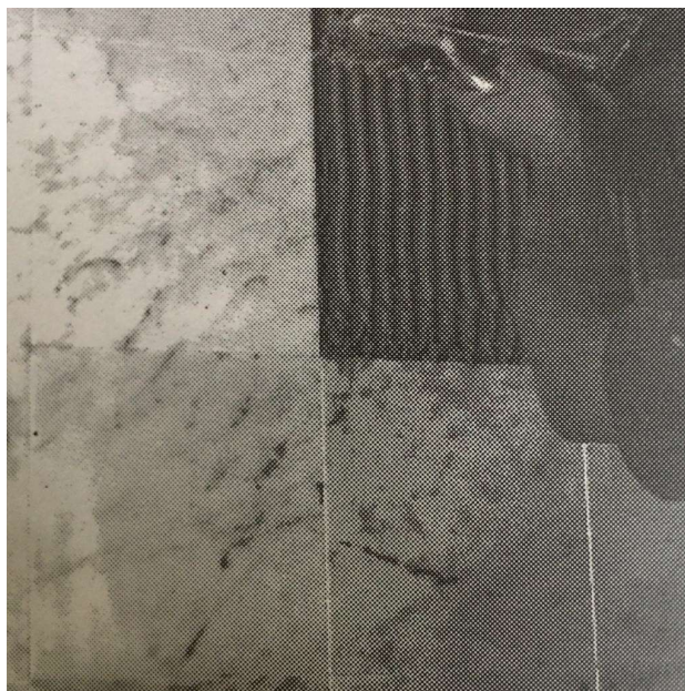
Slika 5-4 Oblaganje unutarnjeg zida marmetama (preuzeto iz Crnković i Šarić, 2003)
