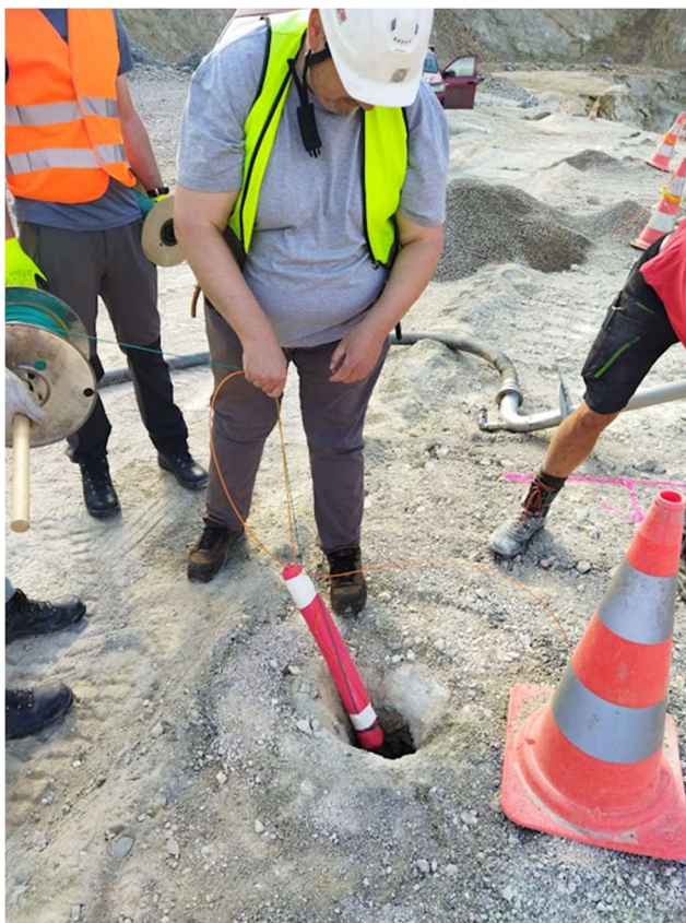
Slika 6-1. Spuštanje udarne patrone mjernog kabela u bušotinu
