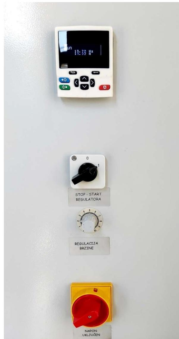
Slika 2-11. Upravljačka ploča ventilatora
