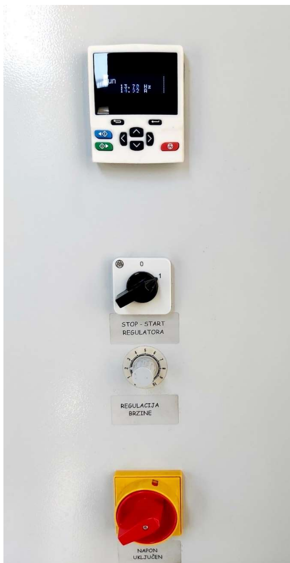
Slika 2-11. Upravljačka ploča ventilatora
