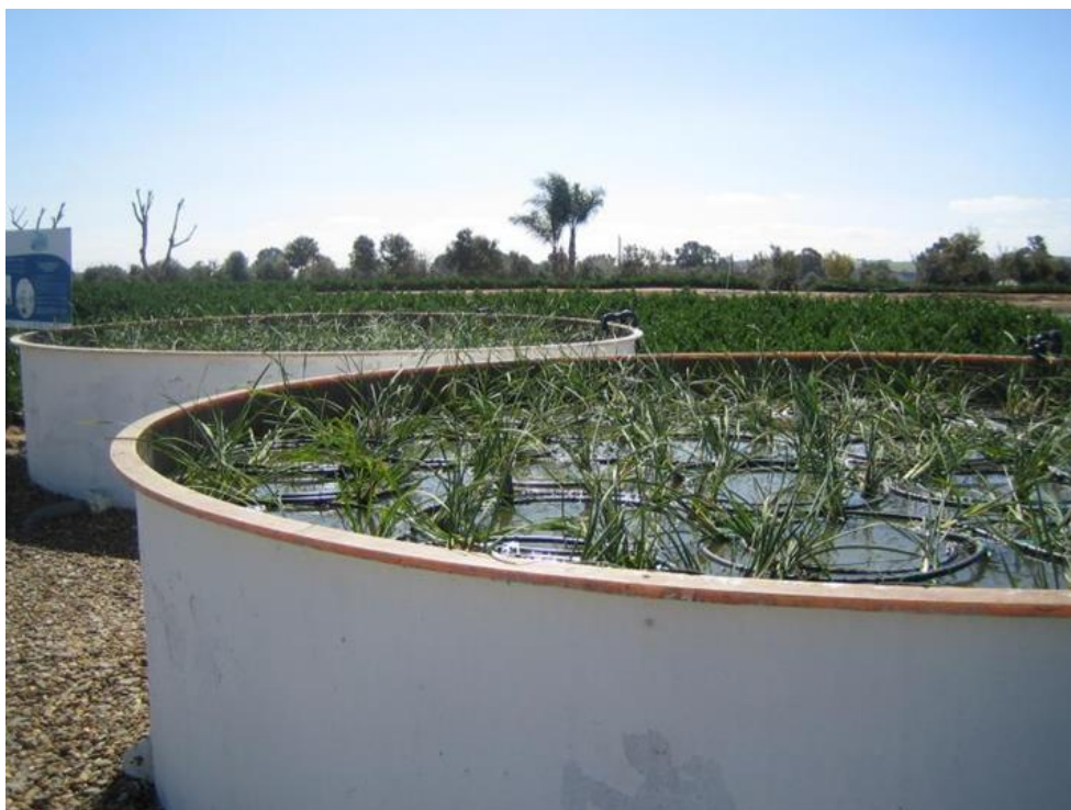
Slika 3-4. Površinski biljni uređaji ( Emajstor, 2022)
