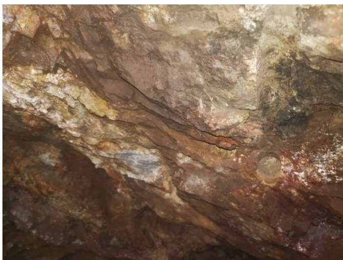
Slika 6-5. Stijena nakon prvog miniranja.
