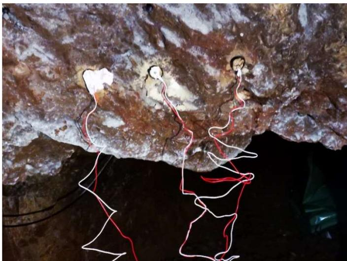
**Slika 6-3.** Napunjene bušotine opremljene električnim detonatorima.
