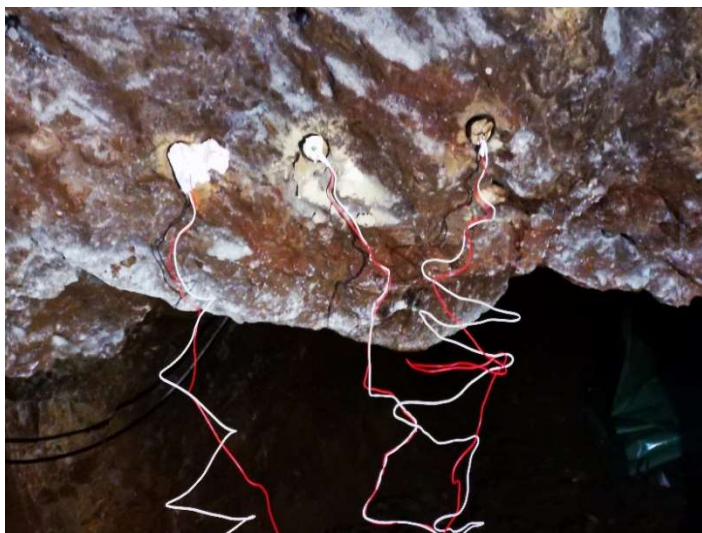
Slika 6-3. Napunjene bušotine opremljene električnim detonatorima.
