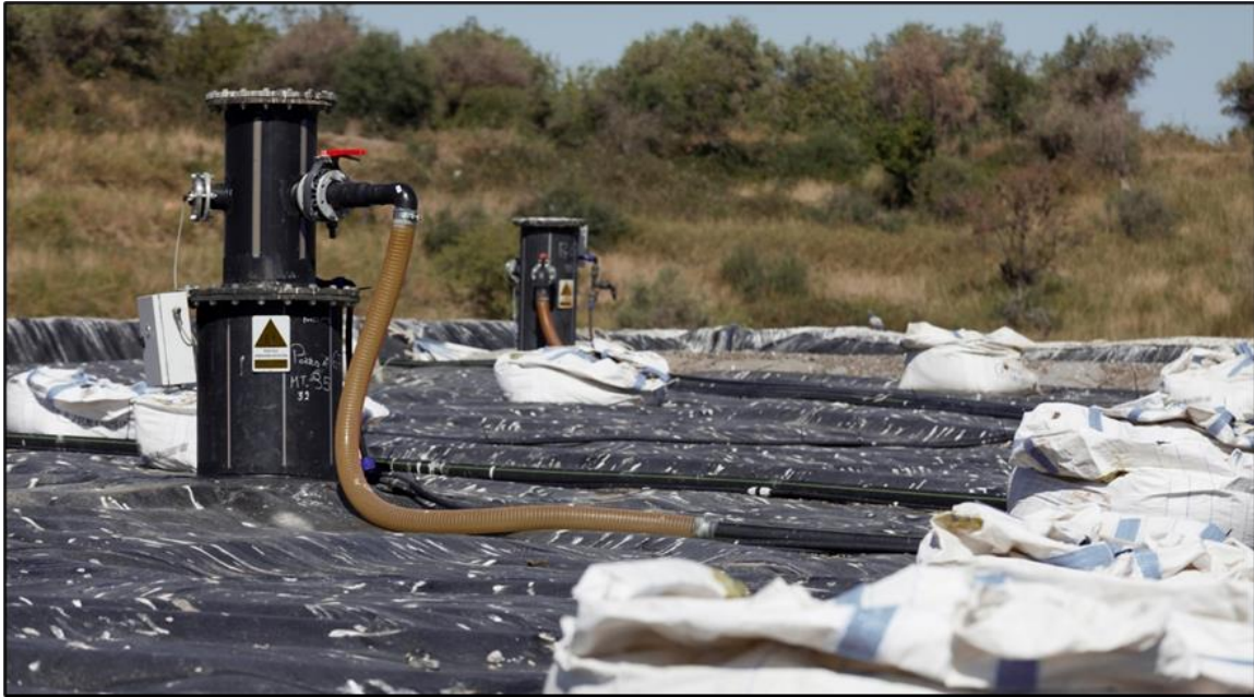
Slika 3-5. Bušotine za proizvodnju bioplina na neuređenom odlagalištu komunalnog otpada (ZORG, 2023)
