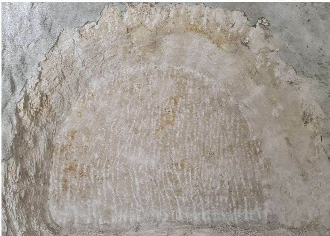
Slika 7-19. Iskop u rudistnom vapnencu gornje krede II. kategorije stijenske mase na stacionaži 31+158,00
