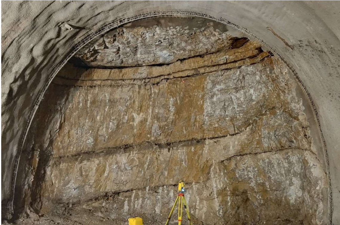
Slika 7-3. Iskop u pločastom vapnencu IV. kategorije stijenske mase na stacionaži 30+612,00
