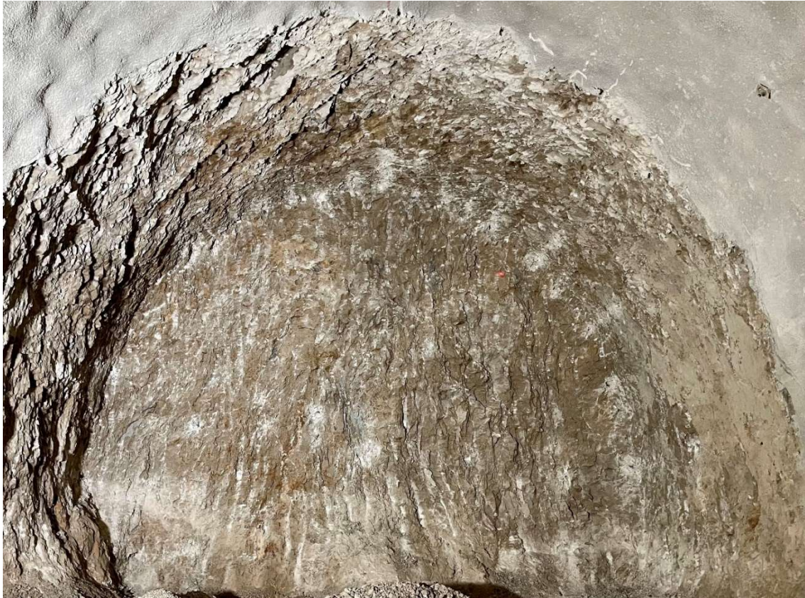
Slika 7-22. Iskop u foraminiferskom vapnencu III. kategorije stijenske mase na stacionaži 33+006,50
