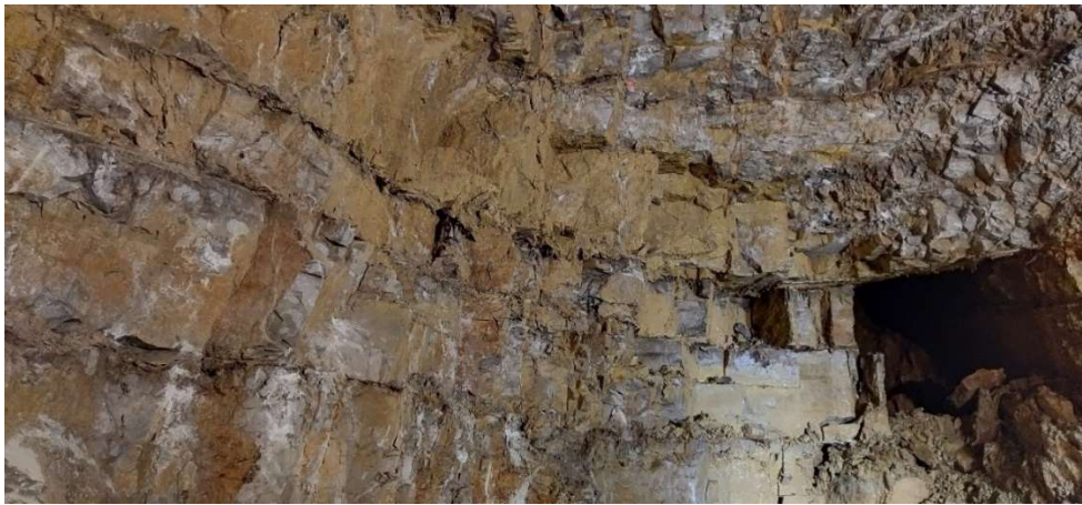
Slika 7-6. Prikaz slojnih ploha s glinovitom ispunom na stacionaži 30+667,50
