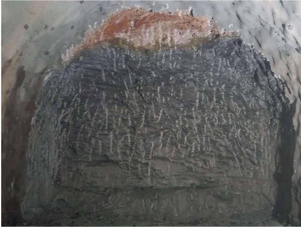
Slika 4-7. Prijelazna zona u kojoj se na čelu iskopa nalaze foraminiferski vapnenac i lapor na stacionaži 33+646,50
